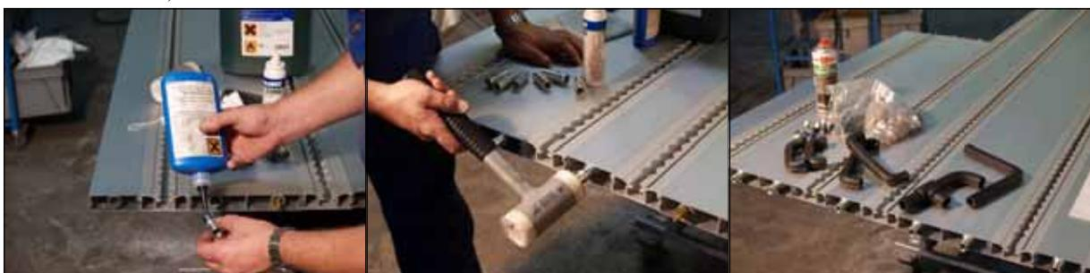
Rohrreiner in das nächste Rohr stecken. So weiß man jederzeit, wo man gerade ist. Loctite am Schlauch-Anschlussstück zwei Mal ringsherum auftragen (darauf achten, dass Loctite mind. 2 mm vom Rand entfernt ist)
