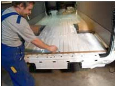
Position der Schienen des SpaceFloor auf dem Fahrzeugboden markieren. (Zur Übertragung der Position kann beispielsweise ein Stück Holz verwendet werden.) Jetzt ist die Position für das Einleimen bekannt.
