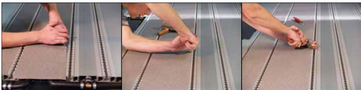
Das Werkzeug wird ungefähr einen Meter entlang der Schiene geführt. Dann an der anderen Seite fortsetzen. So wird nach und nach der gesamte Boden belegt.
