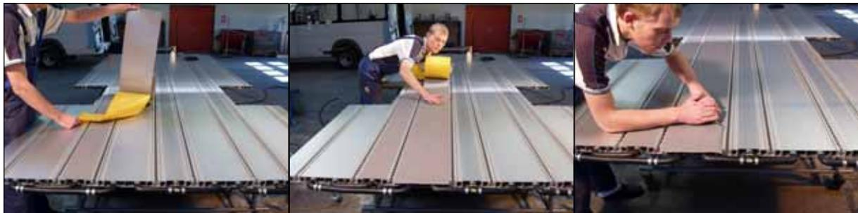
Wenn der Bodenbelag breiter als 173 mm ist, wird nur ca. 1 Meter des Schutzfilms vom Klebeband abgezogen.
