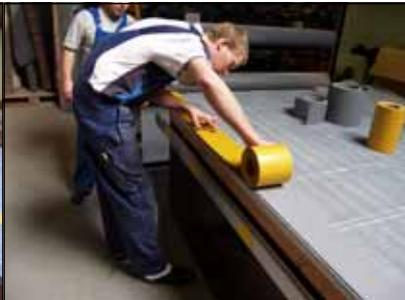
Applicare il nastro biadesivo Martech sul retro del tappeto. In alternativa è possibile applicare il nastro biadesivo Martech direttamente su SpaceFloor.
