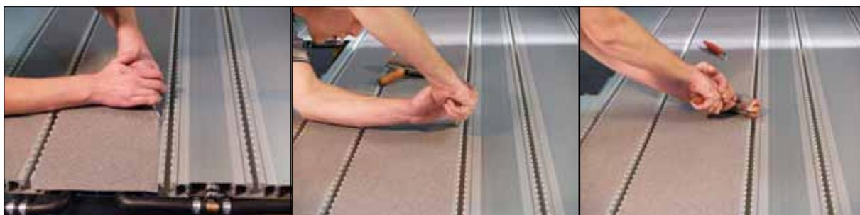
Muovere l'utensile lungo la guida per circa un metro e proseguire sull'altro lato. Continuare per l'intera lunghezza del pavimento.
