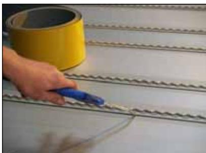
Dopo aver preparato i pezzi, iniziare a rivestire il pavimento. Pulire SpaceFloor con la pistola ad aria compressa per eliminare eventuali tracce di sporcizia e residui di alluminio prodotti durante il taglio.
