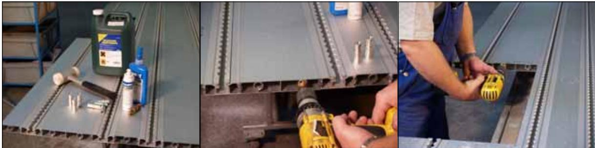
Ecco l'occorrente per introdurre il tubo di alluminio (raccordo) nel pavimento.
